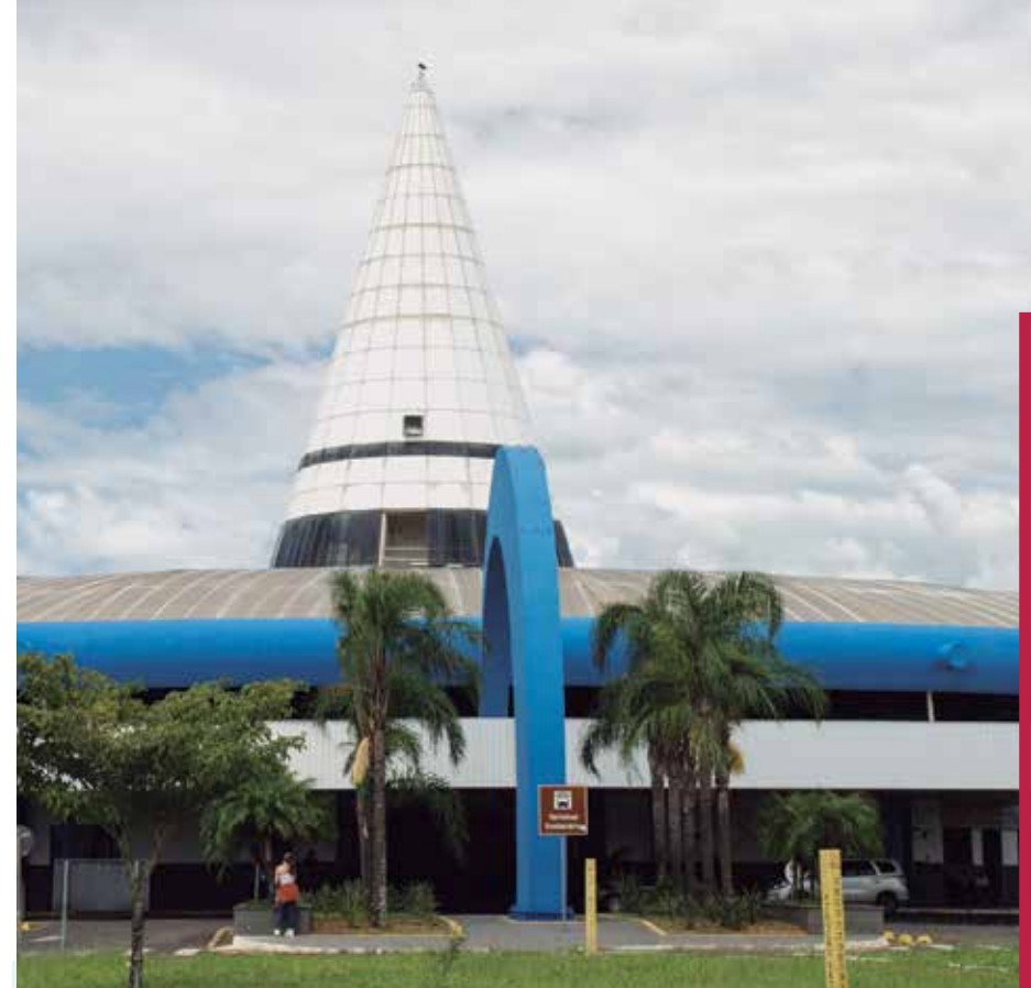
A partir da esquerda: Rua São Luiz, no centro de Marília, e a rodoviária
